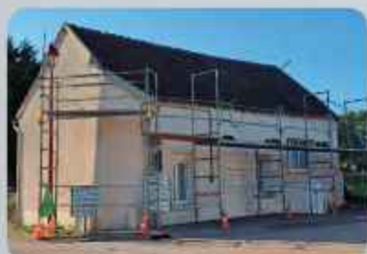
Toiture maison - 8 Grande Rue.
